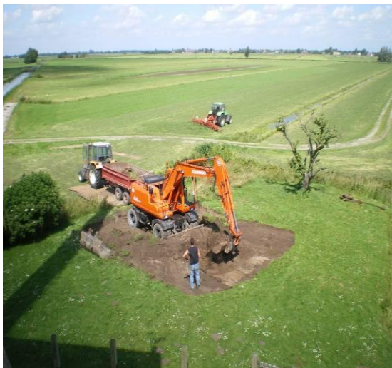
Het graafwerk (foto Harke Slagter)
