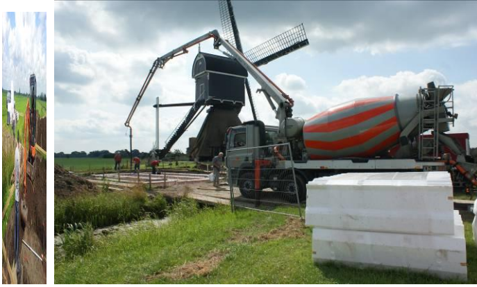
Funderingswerkzaamheden (foto Erik Stoop) Betonstorten (foto Erik Stoop)
