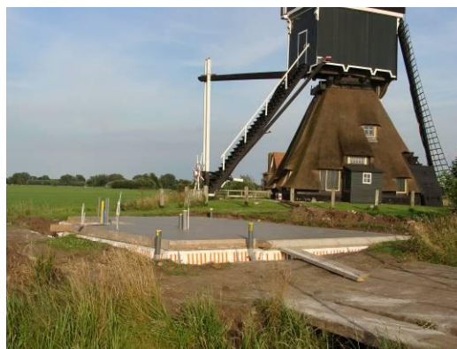
De fundering kan uitharden (foto Jan Dirk Schinkel)
