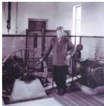
Machinist Jos Noorlander bij de elektromotor in het gemaal.
