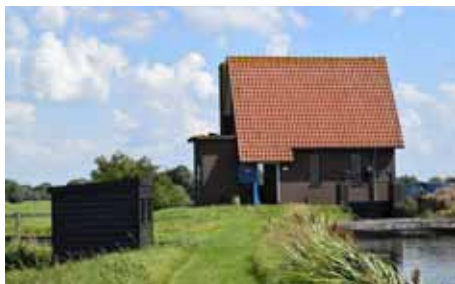
Noodbemaalingsinstallatie en gemaal
